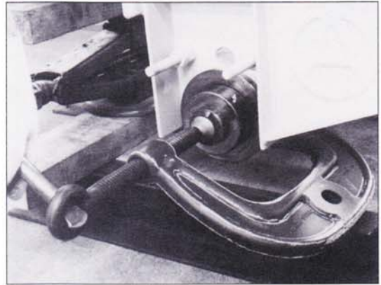
⑤ シャコ万力で車輪を軸にはめ込む。 ストップリングを軸にはめ込み固定させます。 押し上げたジャッキを降ろしレールに車輪を乗せます。 転倒防止金具を取付け完了します。
